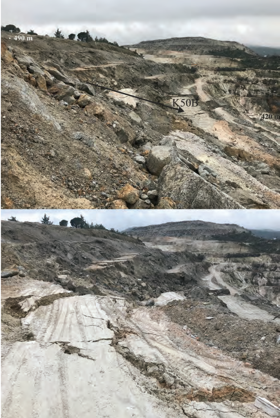
Şekil 1. Yenilme sonrası heyelan topoğrafyası (Foto:19.12.2018, sabah-7.30).
